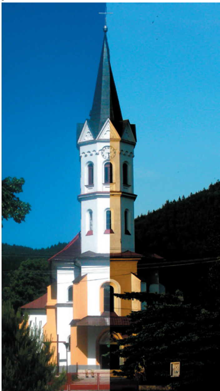
Naľavo po rekonštrukcii veže a fasády, napravo pred rekonštrukciou
